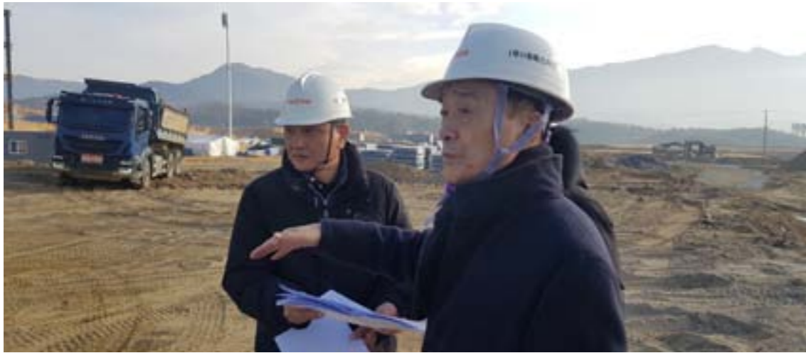
2020.01.23 청안캠퍼스 건설 현장
