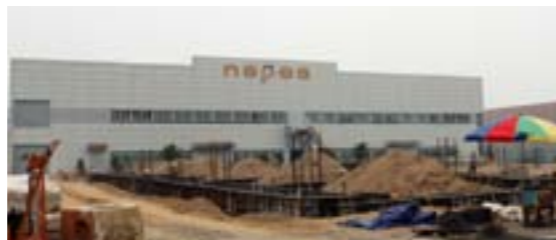
청주2캠퍼스(前 오창2공장)을 증설하면서 경남 마산의 디스플레이 공장을 옮겨왔다. 네패스ENC가 공장 증축 공사를 하고 있는 장면이다.
