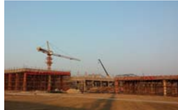
2014.12.19 중국 장쑤네패스 반도체 공장 건설 현장
